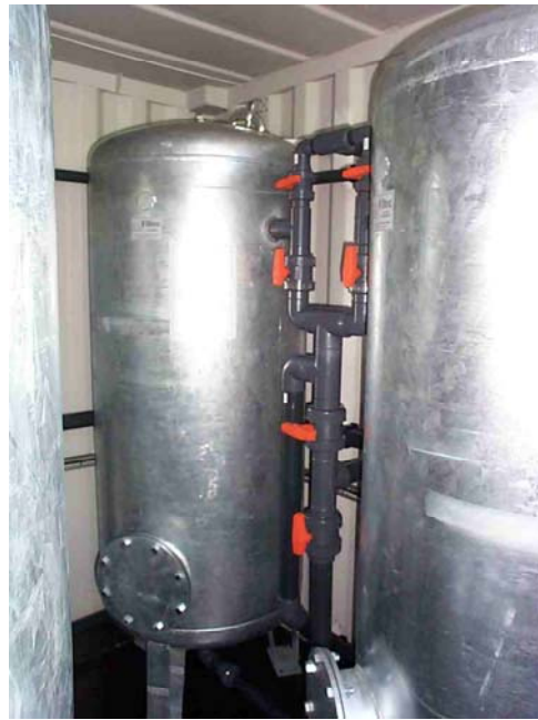
Eksempel på Tvilling filteranlæg indbygget i 10 fods containere
