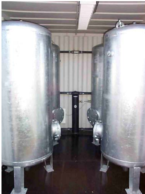
Eksempel på Tvilling filteranlæg indbygget i 10 fods containere
